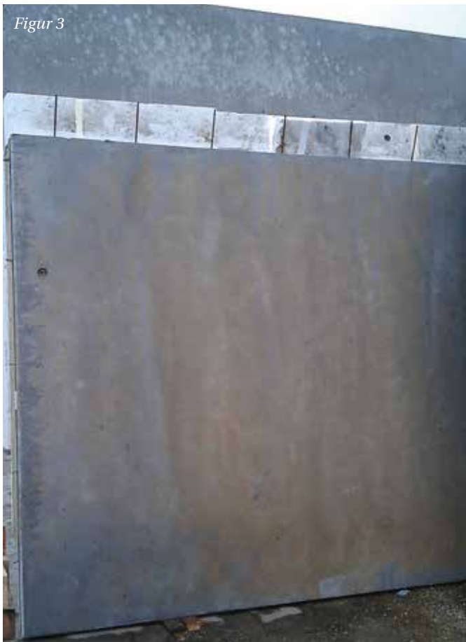
På figur 3 er vist et eksempel på en brun misfarvning. Dette er et fænomen som viser sig i perioder, og optræder på såvel lodrette som vandrette overflader. Den brune farve står i nogen kontrast til betonens andre nuancer i gråt eller hvidt, og er en type af misfarvning, der ofte giver anledning til reklamationer.
